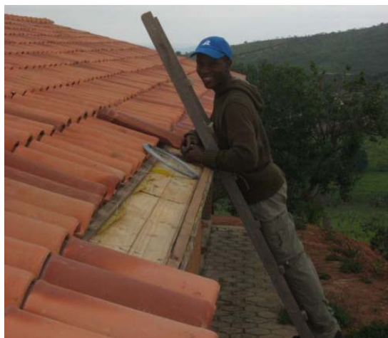
Dieuseul plaatst nieuwe dakpannen.
